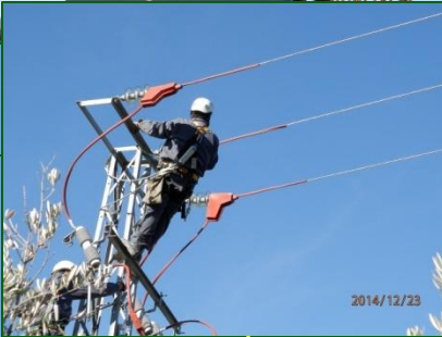
Instalación de los diferentes Dispositivos de Silicona CAON-KORWI sin herramientas. Fácil adaptación sobre el Apoyo.
