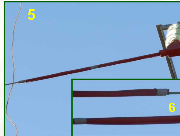
Imagen 5 : Encintado de seguridad del cierre mediante cinta de silicona autovulcanizable en frío , Mod. X-TREME de MOCAP®
