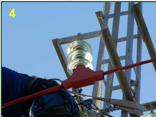
Imagen 2 : Facilidad de corte , instalación y cierre del protector Mod. SWP-12 incluso a bajas temperaturas.
