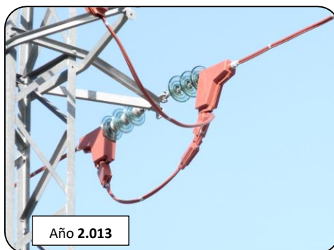
Bulones cónicos preinstalados. Apertura de los forros en forma de "concha".
