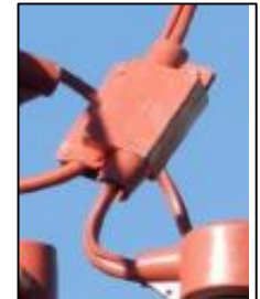
Capacidad de adoptar radios cortos sin aperturas del forro para el conductor.
