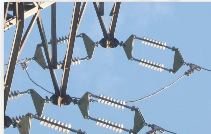
Imagen 1. Instalación dotada de Cadenas de Amarre Dobles Poliméricas .
