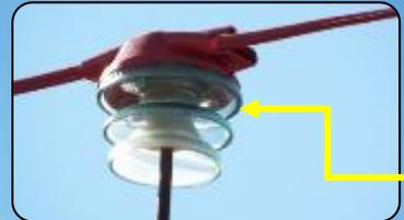
Instalación del Protector de Silicona mod. **SPAV** sobre aisladores de vidrio tipo **ARVI-42**
