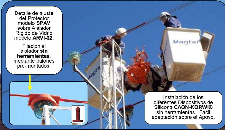
Detalle de ajuste del Protector modelo **SPAV** sobre Aislador Rígido de Vidrio modelo **ARVI-32**.
