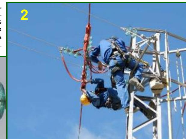
Imagen 3 : Fijación segura del protector SWP-12 a la grapa mediante el uso de dos (2) bridas de acero inoxidable.
