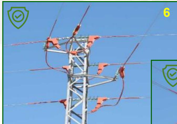
Imagen 8 : Encintado de seguridad del cierre del protector SWP mediante cinta de silicona autovulcanizable en frío , Mod. XTREME de MOCAP®, con detalle del encintado en el cono , - medida extra de seguridad -, para impedir el deslizamiento del protector SWP sobre el conductor y vista del cierre del extremo más alejado de la grapa , sin cegar la salida del protector SWP , para permitir el drenaje.
