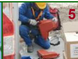
Imágenes 4 y 5 : Facilidad de corte , montaje y adaptación del Cubre-Grapas STSC a las necesidades de la instalación. Aislamiento integral de Rótula y Grapa de Amarre. Interacción con el dispositivo SAP para cubrir los conectores y empalmes existentes, incluso en aquellos complejos por su proximidad a la grapa de amarre.
