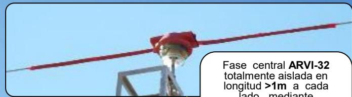
Fase central **ARVI-32** totalmente aislada en longitud >1m a cada lado , mediante Protectores de Silicona **CAON-KORWI®** modelos **SWP - SPAV**.
