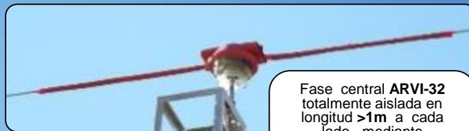
Fase central **ARVI-32** totalmente aislada en longitud **>1m** a cada lado , mediante Protectores de Silicona **CAON-KORWI®** modelos **SWP - SPAV**.
