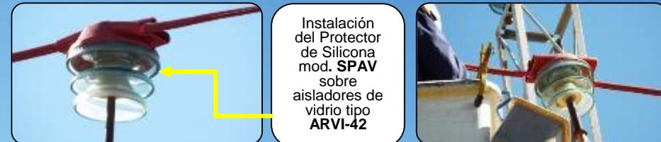
Instalación del Protector de Silicona mod. **SPAV** sobre aisladores de vidrio tipo **ARVI-42**
