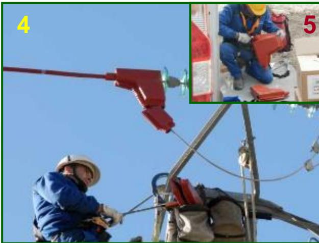
Imágenes 4 y 5 : Facilidad de corte , montaje y adaptación del Cubre-Grapas STSC a las necesidades de la instalación. Aislamiento integral de Rótula y Grapa de Amarre. Interacción con el dispositivo SAP para cubrir los conectores y empalmes existentes, incluso en aquellos complejos por su proximidad a la grapa de amarre.
