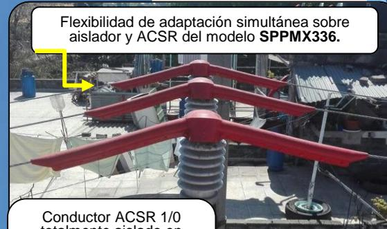
Conductor ACSR 1/0 totalmente aislado en longitud >1m ,mediante el Protector de Silicona **CAON-KORWI®** modelo **SPPMX**.
