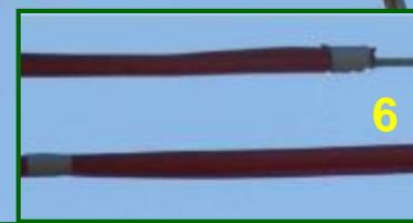
Imagen 6 : Detalle del encintado en el extremo más alejado de la grapa , sin cegar la salida del protector SWP , para permitir el drenaje.
