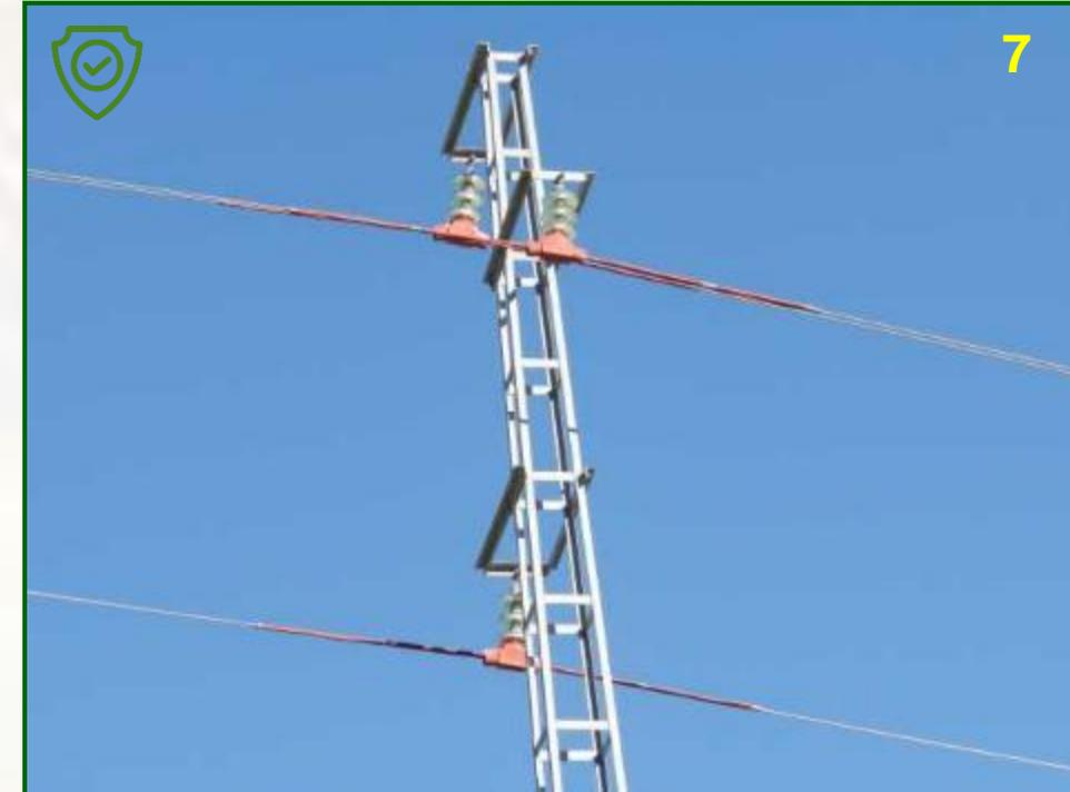
Imagen 7 : Apoyo aislado según RD-1432/2008\_ BOJA 209.
