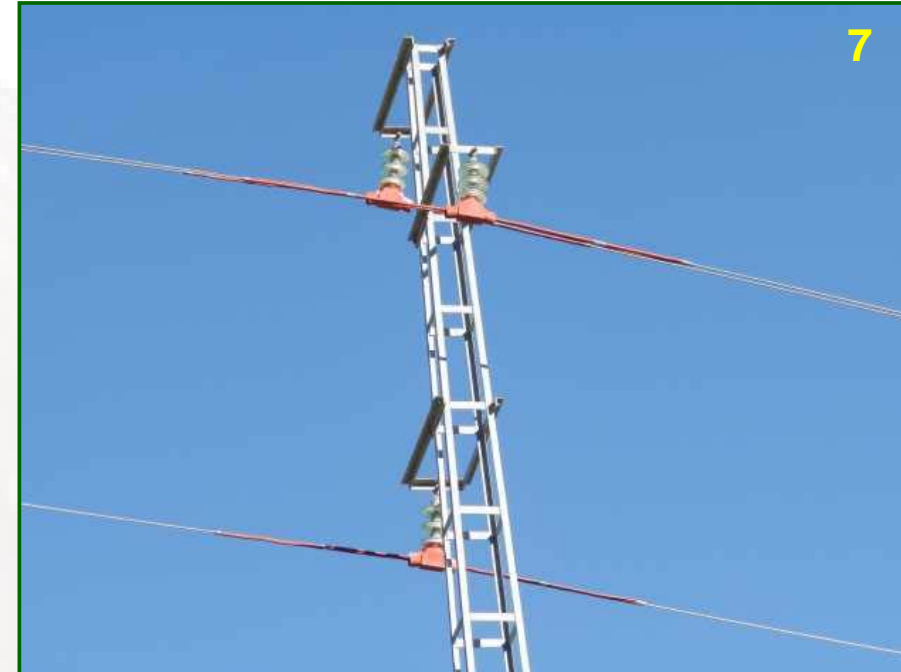
Imagen 6 : Detalle del encintado en el extremo más alejado de la grapa , sin cegar la salida del protector SWP , para permitir el drenaje.
